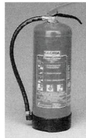
**JEDER FEUERLÖSCHER MUSS ALLE 2 JAHRE AUF SEINE FUNKTION ÜBERPRÜFT WERDEN!**
