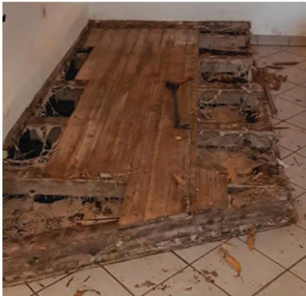
Beim Abbau der Fußböden zeigte sich, dass der Schaden weitreichender war, als zuvor vermutet. Die Ursache wurde an der Außenseite der Kapelle rasch identifiziert: Desolate Regenrinnen-einläufe und Stauwasser vom umliegenden Gelände.
