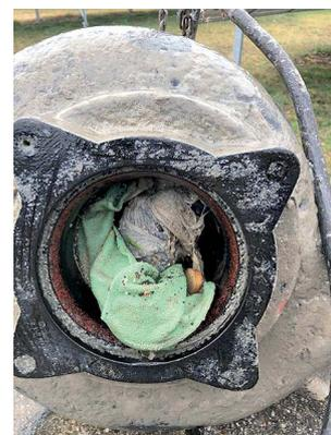
**In der Abbildung rechts sehen Sie eine Zulaufpumpe in der Kläranlage, welche zerlegt werden musste!**
