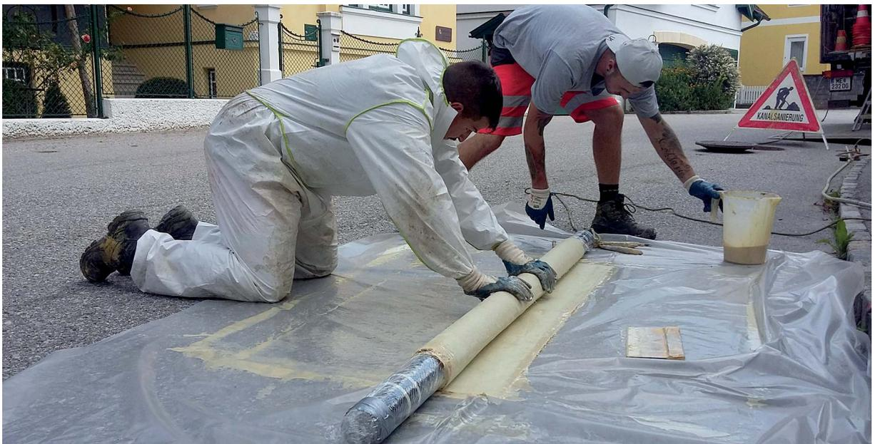
Das Netz mit getränkter Dichtmasse wird um den Schlauch gerollt (Hauptstraße in Gleißfeld)
